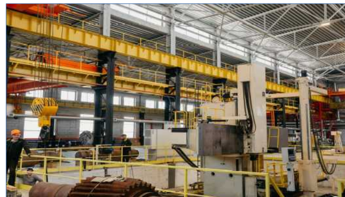
Модернизация литейного и механического цехов ООО «КЭВРЗ»
