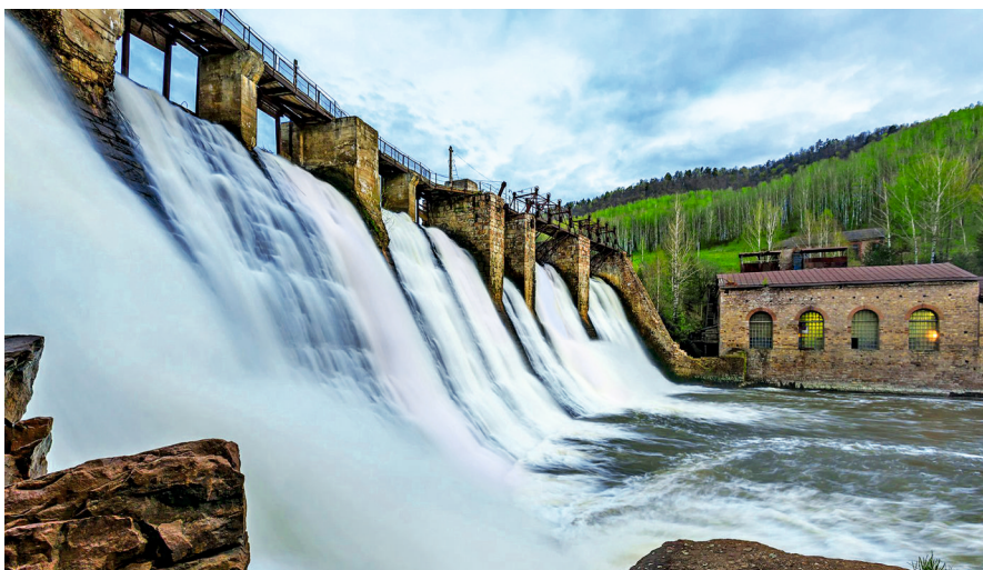
Плотину построили по проекту известного ученого, инженера-гидравлика Б. А. Бахметьева. Выложена плотина из дикого бутового камня
