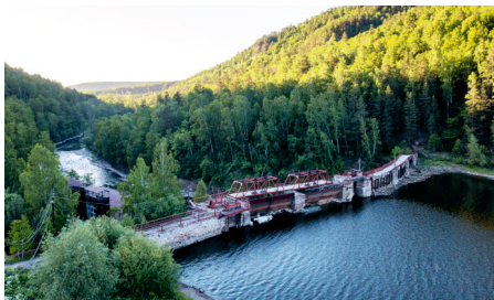
Плотину построили по проекту известного ученого, инженера-гидравлика Б. А. Бахметьева. Выложена плотина из дикого бутового камня
