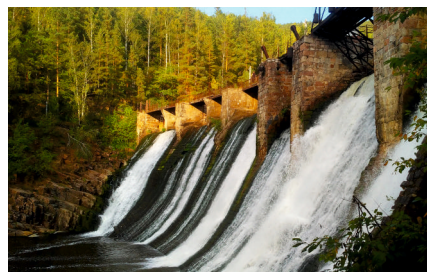
Плотину построили по проекту известного ученого, инженера-гидравлика Б. А. Бахметьева. Выложена плотина из дикого бутового камня
