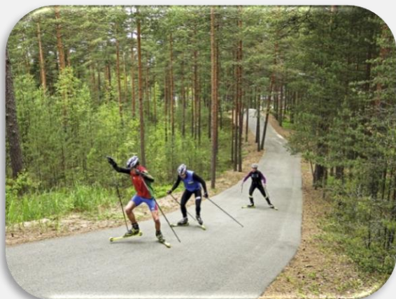
Строительство лыжероллерной трассы
